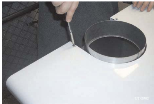
Fig. 3 - Quitar los dos tornillos autoroscantes que hay en la tapa de la caldera.
